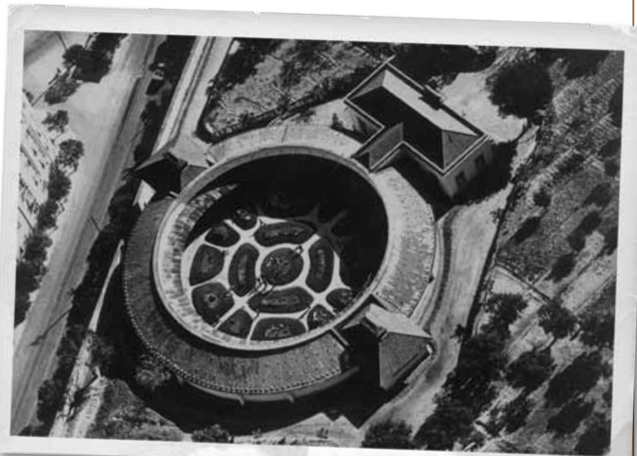
O Pavilhão de Segurança, construído em 1896, é um dos sete edifícios panópticos existentes no mundo
